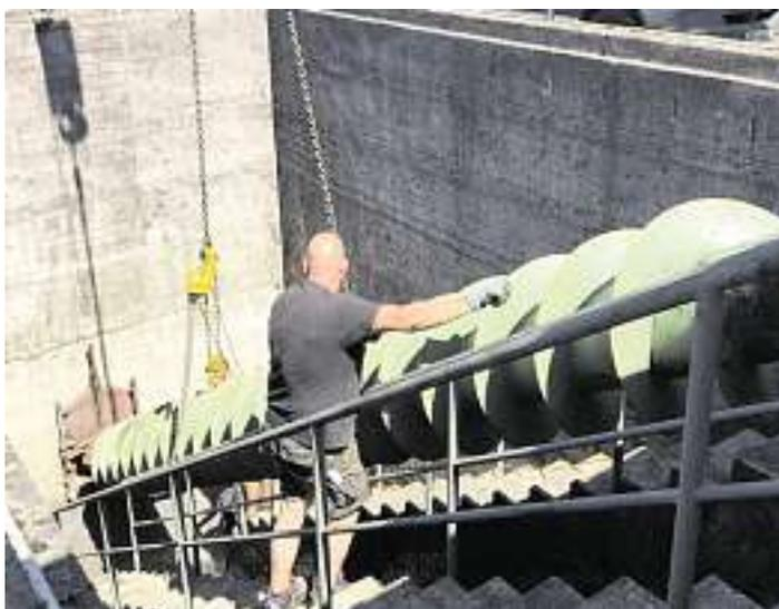
Die drei Förderschnecken an der Kläranlage Achern konnten bereits demontiert werden.
