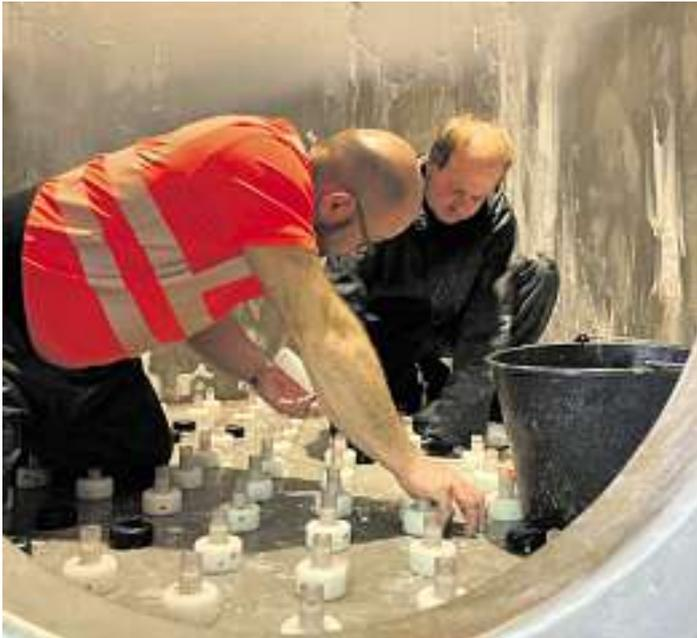
Martin Huber und Rolf Spraul kontrollieren und reinigen die Düsen im Enthärtungsreaktor
